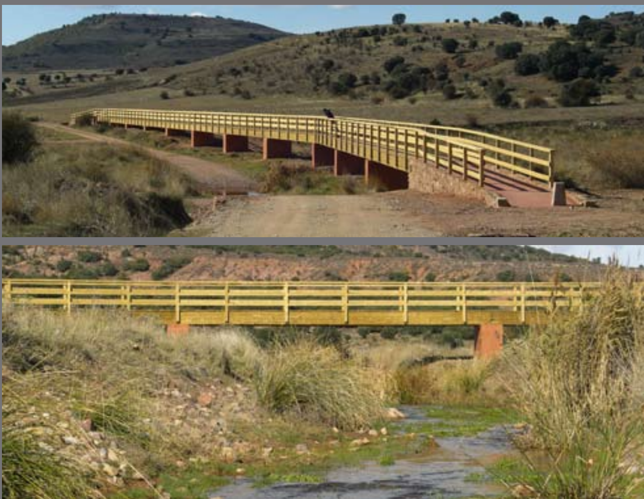
Ruta de Don Quijote. Pasarela sobre el Río Salado en Riba de Santiuste. Guadalajara.
